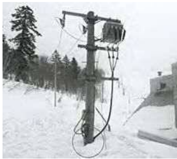
制御線が雪に埋没
