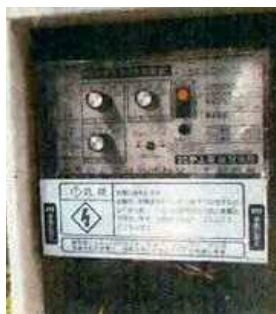
方向地絡継電器(DGR)動作表示
