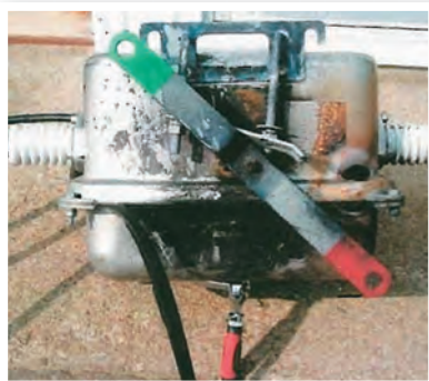
噴出した煤(開閉器側面)
