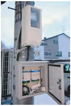
デマンド監視装置の設置状況
