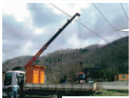
送電線接触状況
