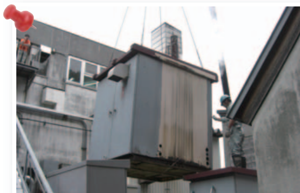
キュービクル撤去作業
