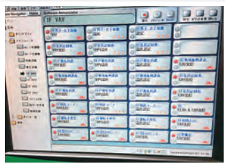
南区役所 温度管理用 タッチパネル式設定器
