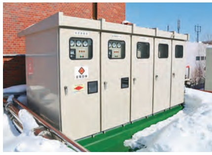
南区役所 屋上キュービクル(外観)
