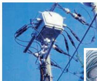
事故を起こした開閉器
