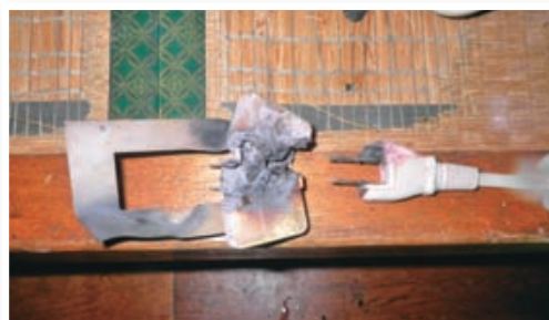
配線接続部の過熱
