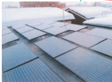
△ 屋根の設置面
