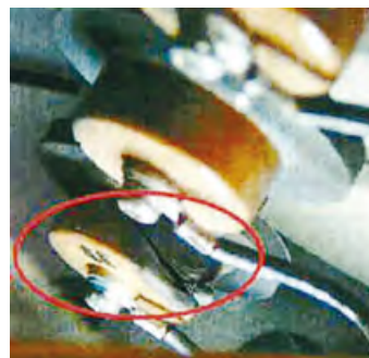
焼損した機器(ZPC)
