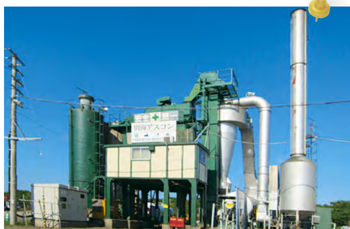
別海アスファルト混合所(外観)
