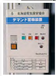
デマンド警報装置
