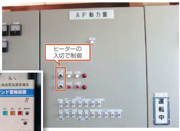
ヒーター制御盤
