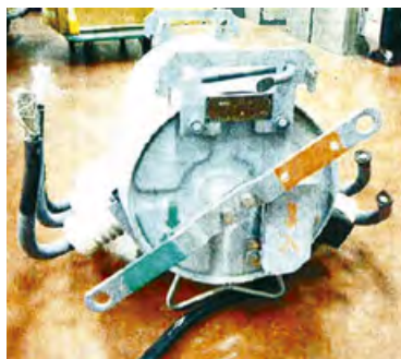
事故を起こした開閉器
