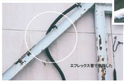
絶縁破壊箇所
