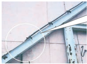
高圧引き込みケーブルを直付け
