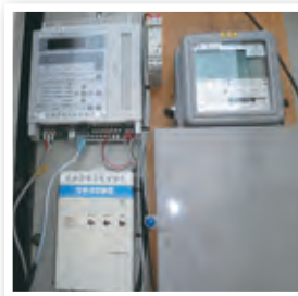
キュービクル内に設置の デマンド監視装置
