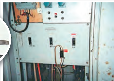
保護装置の電源ブレーカー
