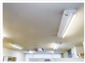
照明器具のLEDへの交換 (蛍光灯、ダウンライト)
