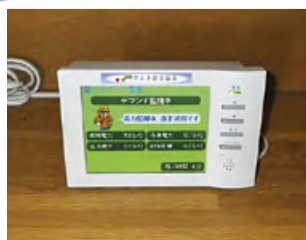
デマンド監視装置のモニターをレジの横に置き常に電気の使用状況を確認できます。
