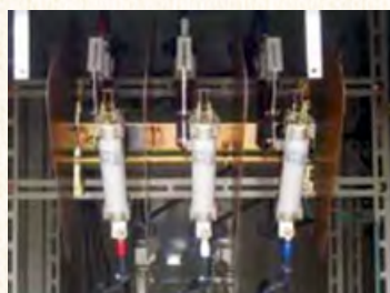
ヒューズ付き高圧交流負荷開閉器
