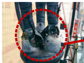
三叉分岐管の焼損痕
