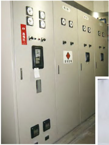
電気室キュービクル
