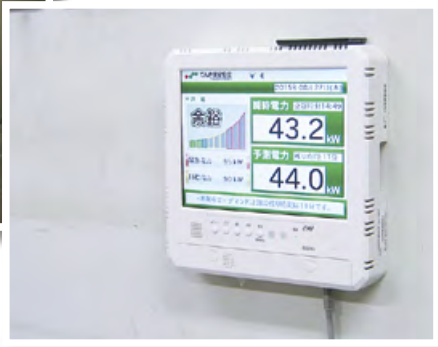
電力使用量が常時モニターで確認できます。
