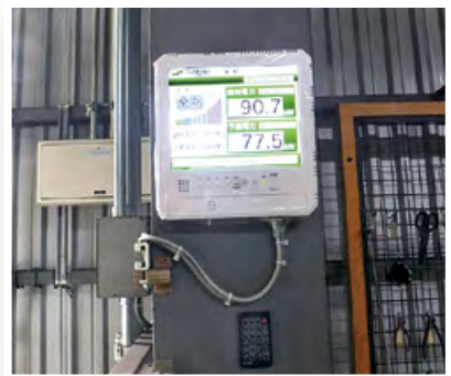
広い室内でも見やすくなったデマンド監視装置の電力管理モニター
