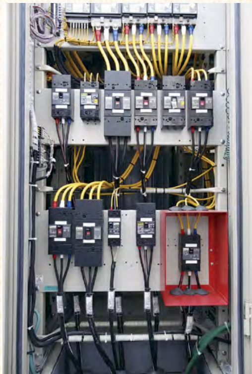
配線用しゃ断器(MCCB):表面型 表面
