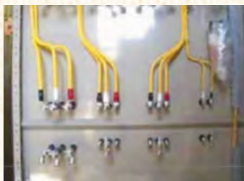
配線用しゃ断器(MCCB):裏面型 裏面
