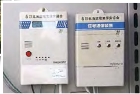
キュービクル内に設置した デマンド監視装置
