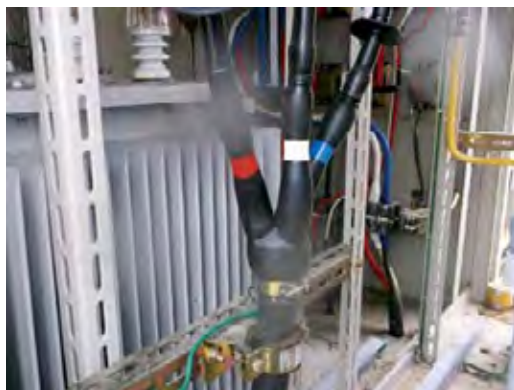
膨張した高圧ケーブル三又分岐管
