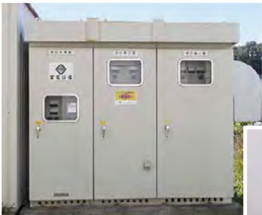
屋外高圧受電設備キュービクル
