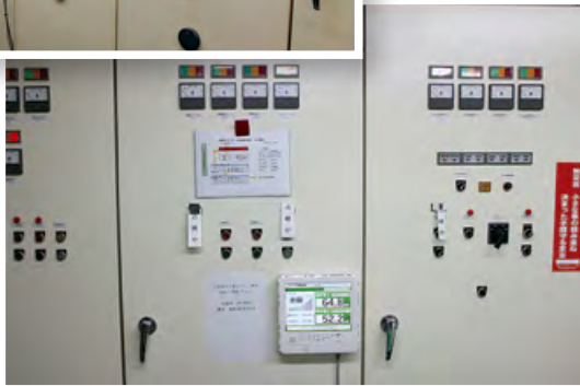
デマンド警報表示器と動力制御盤 遠方自動操作盤
