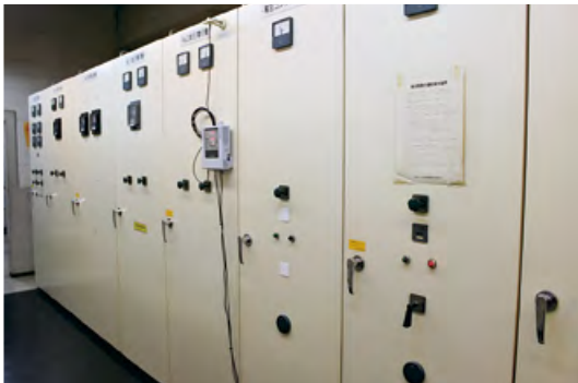
屋内高圧受電設備 キュービクル
