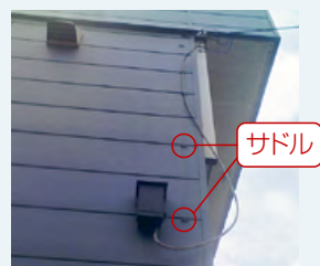
サドルから配線が外れている様子
