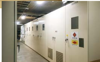
屋内高圧受電設備キュービクル
