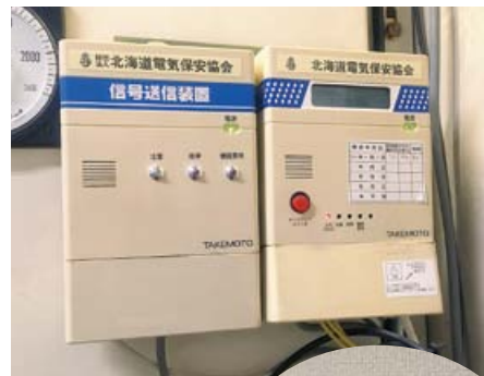
デマンド監視装置 本体
