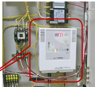
一階電灯盤内のデマンド表示器
