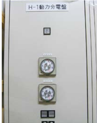
デマンド制御するロードヒーティング盤
