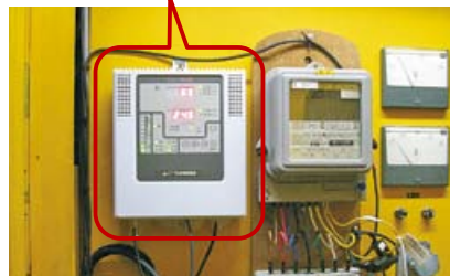
キュービクル内のデマンド監視装置
