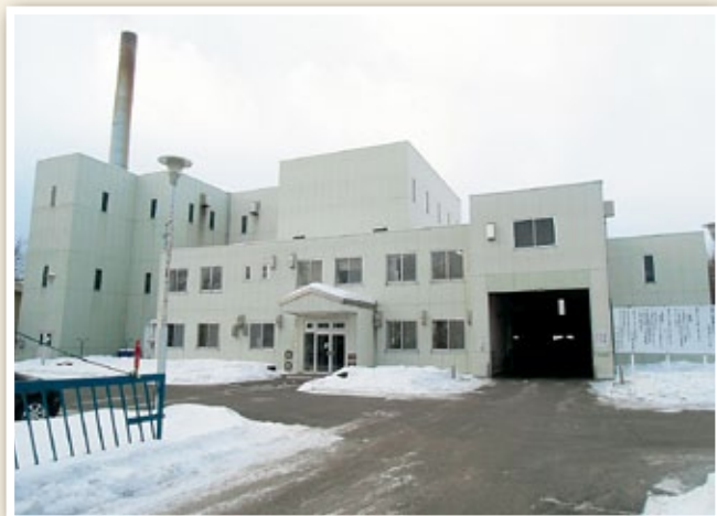
清水町清掃センターさま(外観)
