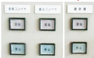
中央監視盤の運転ボタン
