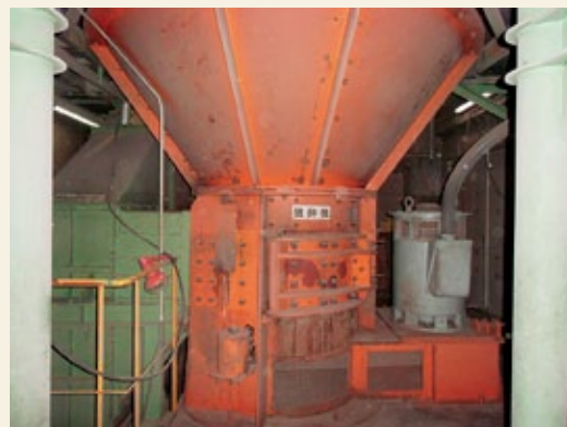
破砕機 (清掃センターの中で最も電力を消費します)
