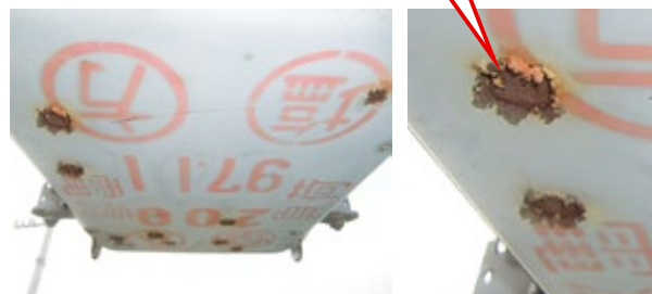
塗装が剥がれ、めくれた箇所に錆が発生した様子
