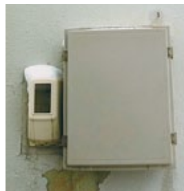
引込開閉器のボックスの外観
