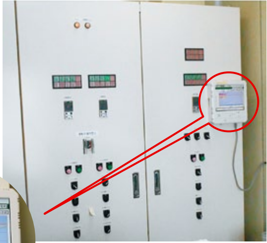
事務所に設置された冷凍機の操作盤
