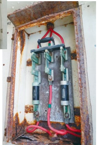
変色し、錆と腐食が進んでいる ボックスの内部
