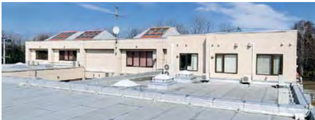
エアコンの室外機が設置されている屋上
