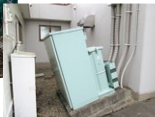
大きく傾いたキュービクル （苫小牧市内）
