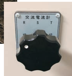
正常な電流計切替器 (正面)
