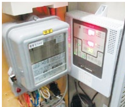
デマンド監視装置
