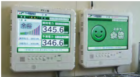
デマンド監視装置
