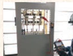
高圧絶縁抵抗測定(例)
