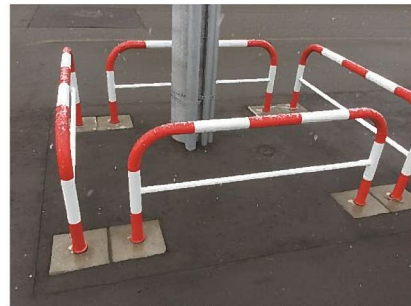
改修が終了した電柱
