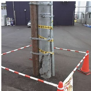
電柱の仮補修中のようす
