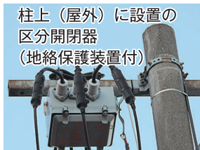
柱上（屋外）に設置の 区分開閉器
