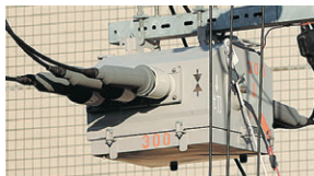
柱上（屋外）に設置の 区分開閉器
