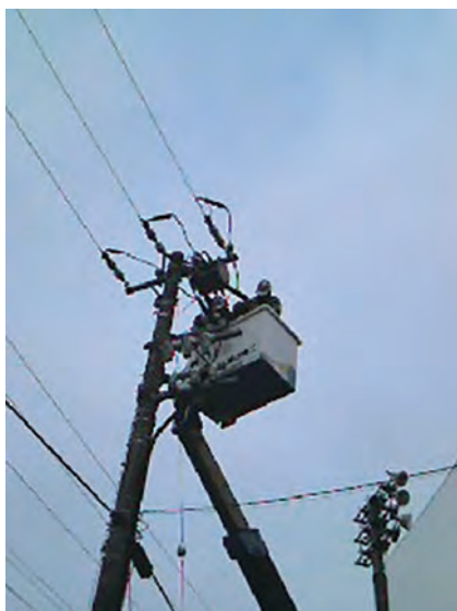
屋外ケーブルの点検のようす
