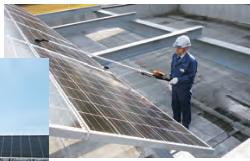
スーパーラインチェッカーによる配線診断
