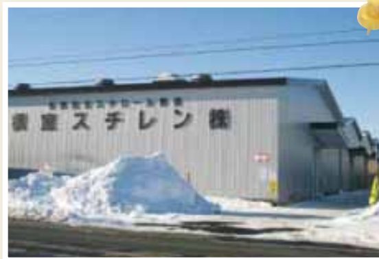
根室スチレン株式会社(外観)
