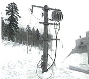
制御線が雪に埋没
