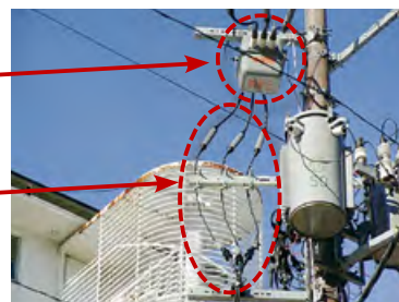
交換後の分岐 PAS(SOG 付)と引込ケーブル
