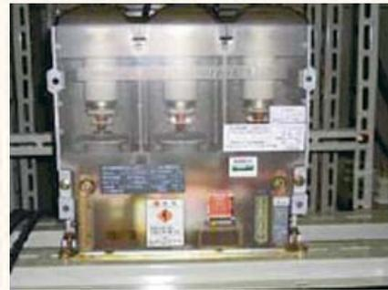
真空電磁接触器 (VMC)
