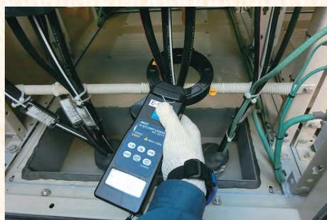
三相回路一括による漏れ電流測定状況
