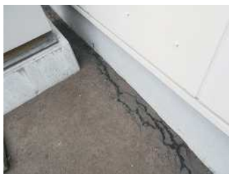
盛り上がった 基礎部分
