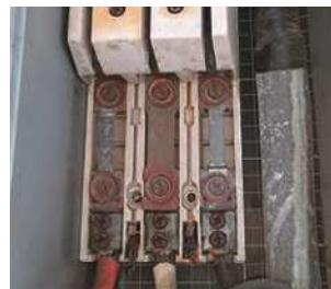
刃型開閉器のカバー脱落および端子部腐食
