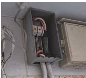
刃型開閉器のカバー脱落および端子部腐食
