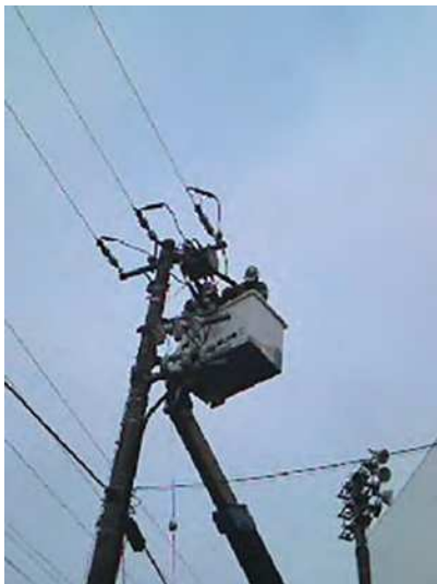
屋外ケーブルの点検のようす
