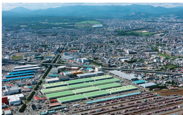
上空から見た建物全景
