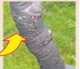
トラッキング発生
