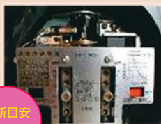
過電流継電器
