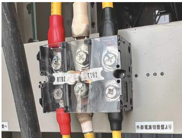
▲白相端子が損傷した電灯回路端子台
