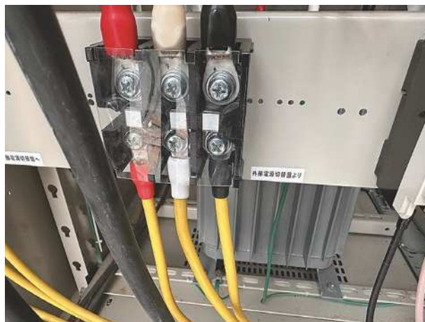
▲改修後の電灯回路端子台
